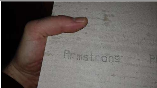
001 : Faux plafonds Entrée + Dégagement
